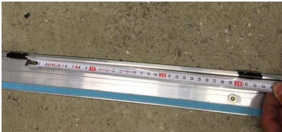
Controllare che le clip siano posizionate correttamente sul profilo, in modo da evitare problemi di assemblaggio nei successivi passi dell'installazione!
