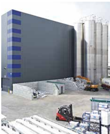
Usine de recyclage à Diksmuide, Belgique
