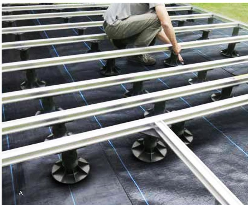
A. La base triangulaire permet une fixation simple et rapide des profilés en aluminium.
