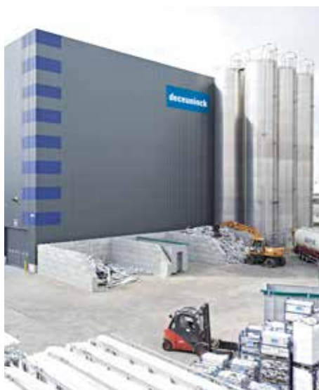
Usine de recyclage à Diksmuide, Belgique
